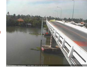
สะพานบุญรัตน์ประชาชนวัดน - อ.สามพราน จ.นครปฐม (ลุ่มน้ำท่าจีน)
