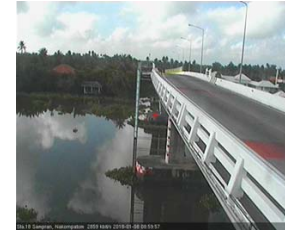
สะพานบุญรัตนประชาวุฒินันท์ - อ.สามพราน จ.นครปฐม (ลุ่มน้ำท่าจีน)
