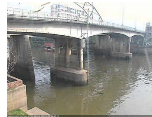
สะพานปรีดีฯ - อ.เมือง จ.พระนครศรีอยุธยา (ลุ่มน้ำเจ้าพระยา)
