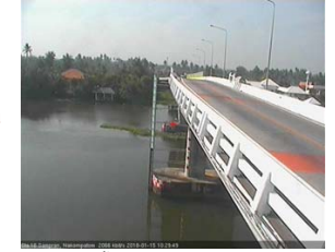
สะพานบุญรัตนประชาคุณวัฒน์ - อ.สามพราน จ.นครปฐม (ลุ่มน้ำท่าจีน)
