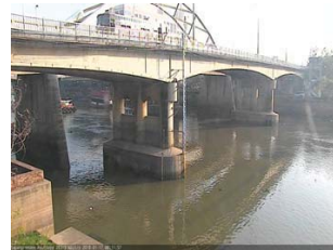
สะพานปรีดี - อ.เมือง จ.พระนครศรีอยุธยา (ลุ่มน้ำเจ้าพระยา)
