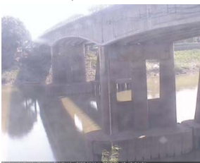
เขิงสะพานลิงห์บุรี - อ.เมือง จ.สิงห์บุรี (ลุ่มน้ำเจ้าพระยา)
