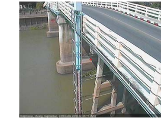
สะพานวัดพระรูป อ.เมือง จ.สุพรรณบุรี (ลุ่มน้ำท่าจีน)
