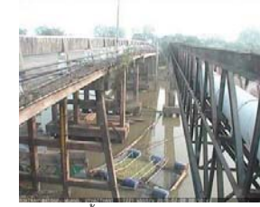
เชิงสะพานบริรักษ์ - อ.เมือง จ.อุทัยธานี (ลุ่มน้ำสะแกกรัง)
