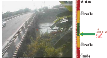
สะพานบ้านโพทะเล - อ.โพทะเล จ.พิจิตร (ลุ่มน้ำยม)
