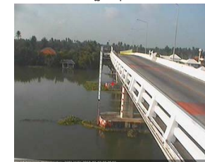
สะพานบุญรัตน์ประชานุวัฒน์ - อ.สามพราน จ.นครปฐม (ลุ่มน้ำท่าจีน)
