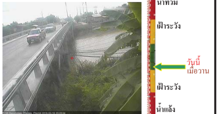
สะพานบ้านโพทะเล - อ.โพทะเล จ.พิจิตร (ลุ่มน้ำยม)
