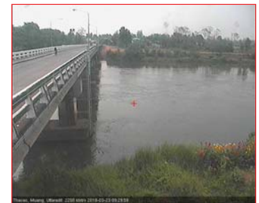
สถานีสะพานท่าเสา อ.เมือง จ.อุดรดิตถ์ (ลุ่มน่าน)
