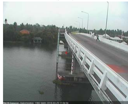
สะพานบุญรัตน์ประชาชนวิรัตน์ - อ.สามพราน จ.นครปฐม (ลุ่มน้ำท่าจีน)
