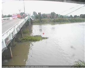
สะพานสามท่ามท่าโบสถ์ อ.หันคา จ.ชัยนาท (ลุ่มน้ำท่าจีน)
