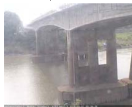
เชิงสะพานลิงห์บุรี - อ.เมือง จ.สิงห์บุรี (ลุ่มน้ำเจ้าพระยา)
