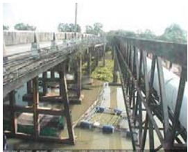
เชิงสะพานวิริรักษ์ - อ.เมือง จ.อุทัยธานี (ลุ่มน้ำสะแกกรัง)
