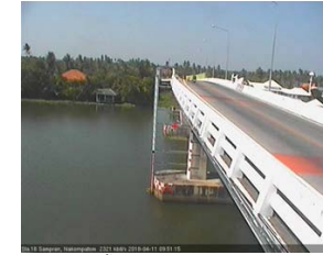
สะพานบุญรัตนประชาคุณวัฒน์ - อ.สามพราน จ.นครปฐม (ลุ่มน้ำท่าจีน)
