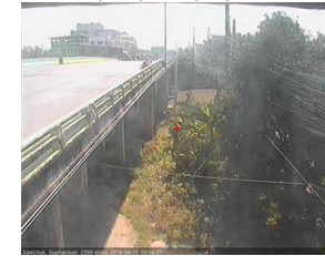
สะพานข้ามแม่น้ำท่าจีน ทางหลวง3365 อ.สามข จ.สุพรรณบุรี (ลุ่มน้ำท่าจีน)
