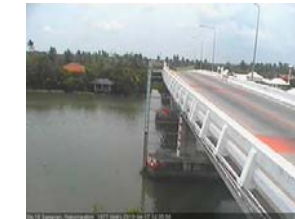
สะพานบุญรัตนประชาชนุวัฒน์ - อ.สามพราน จ.นครปฐม (ลุ่มน้ำท่าจีน)
