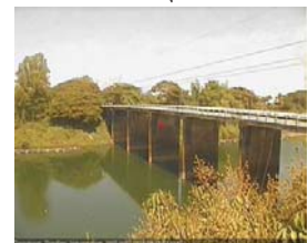
บ้านศาลปากน้ำ - อ.ท่าอุเทน จ.นครพนม (แม่น้ำสงคราม/ลุ่มน้ำโขงอีสาน)
