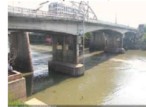
สะพานปรีดีฯ - อ.เมือง จ.พระนครศรีอยุธยา (ลุ่มน้ำเจ้าพระยา)
