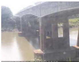
เชิงสะพานลิงห์บุรี - อ.เมือง จ.สิงห์บุรี (ลุ่มน้ำเจ้าพระยา)
