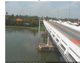
สะพานบุญรัตนประชาชนุวัฒน์ - อ.สามพราน จ.นครปฐม (ลุ่มน้ำท่าจีน)
