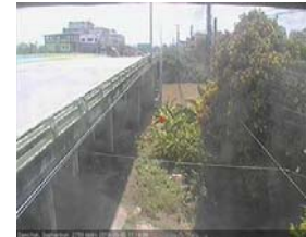
สะพานข้ามแม่น้ำท่าจีน ทางหลวง3365 อ.สามชุก จ.สุพรรณบุรี (ลุ่มน้ำท่าจีน)
