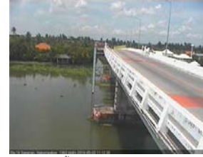
สะพานบุญรัตนประชาอนุวัฒน์ - อ.สามพราน จ.นครปฐม (ลุ่มน้ำท่าจีน)
