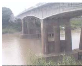
เขิงสะพานสิงห์บุรี - อ.เมือง จ.สิงห์บุรี (ลุ่มน้ำเจ้าพระยา)
