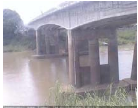
เขิงสะพานสิงห์บุรี - อ.เมือง จ.สิงห์บุรี (ลุ่มน้ำเจ้าพระยา)
