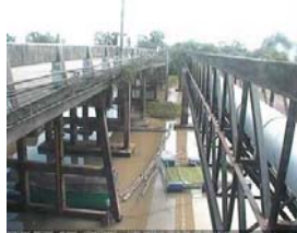
เขิงสะพานบริรักษ์ - อ.เมือง จ.อุทัยธานี (ลุ่มน้ำสะแกกรัง)
