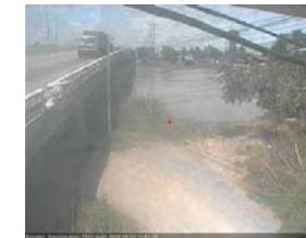
สะพานข้ามแม่น้ำท่าจีน ทางหลวง346 อ.บางเลน จ.นครปฐม (ลุ่มน้ำท่าจีน)
