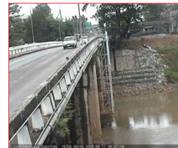
สถานีสะพานศรีสะเกษ อ.ศรีสะเกษ จ.สุโขทัย (ลุ่มน้ำยม)
