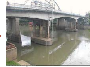
สะพานปรีดีชัย - อ.เมือง จ.พระนครศรีอยุธยา (ลุ่มน้ำเจ้าพระยา)
