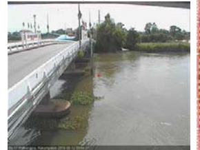
สะพานหลวงพ่อบึง - อ.นครไชยศรี จ.นครปฐม (ลุ่มน้ำท่าจีน)
