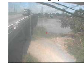
สะพานข้ามแม่น้ำท่าจีน ทางหลวง346 อ.บางเลน จ.นครปฐม (ลุ่มน้ำท่าจีน)
