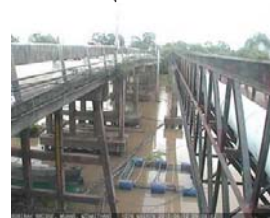
เชิงสะพานบริรักษ์ - อ.เมือง จ.อุทัยธานี (ลุ่มน้ำสะแกกรัง)
