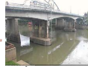
สะพานปรีดีชัย - อ.เมือง จ.พระนครศรีอยุธยา (ลุ่มน้ำเจ้าพระยา)
