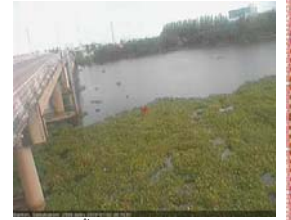
สะพานข้ามแม่น้ำท่าจีน 3 - อ.เมือง จ.สมุทรสาคร (ลุ่มน้ำท่าจีน)
