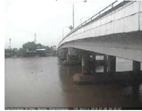
เขิงสะพานฉะเชิงเทรา - อ.เมือง จ.ฉะเชิงเทรา (ลุ่มน้ำบางปะกง)
