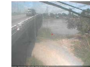
สะพานข้ามแม่น้ำท่าจีน ทางหลวง346 อ.บางเลน จ.นครปฐม (ลุ่มน้ำท่าจีน)
