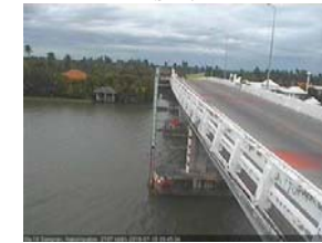
สะพานบุญรัตนประชาวุฒินัน - อ.สามพราน จ.นครปฐม (ลุ่มน้ำท่าจีน)
