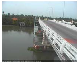
สะพานบุญรัตน์ประชาชนวัดคัน - อ.สามพราน จ.นครปฐม (ลุ่มน้ำท่าจีน)
