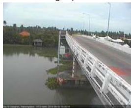
สะพานบุญรัตนประชานาวัฒน์ - อ.สามพราน จ.นครปฐม (ลุ่มน้ำท่าจีน)
