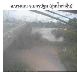
สะพานข้ามแม่น้ำท่าจีน ทางหลวง346 อ.บางเลน จ.นครปฐม (ลุ่มน้ำท่าจีน)
