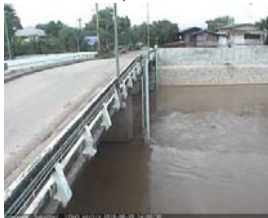
สะพานพระเมรุมา - อ.เมือง จ.สุโขทัย (ลุ่มน้ำยม)
