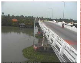
สะพานบุญรัตนประชาวุฒินัน - อ.สามพราน จ.นครปฐม (ลุ่มน้ำท่าจีน)
