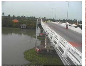
สะพานบุญรัตนประชาวุฒินันท์ - อ.สามพราน จ.นครปฐม (ลุ่มน้ำท่าจีน)
