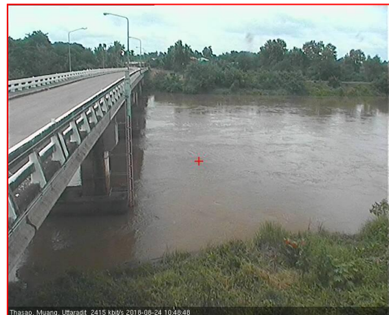
สถานีสะพานท่าเสา อ.เมือง จ.อุตรดิตถ์ (ลุ่มน้ำน่าน)
