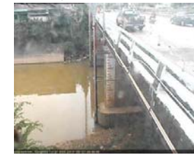
สถานีอุทกภาคอนาล็อก - อ.หาดใหญ่ จ.สงขลา (ลุ่มน้ำทะเลสาบสงขลา)
