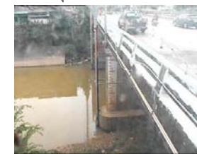
สถานีอุทกภาคอนาล็อก - อ.หาดใหญ่ จ.สงขลา (ลุ่มน้ำทะเลสาบสงขลา)
