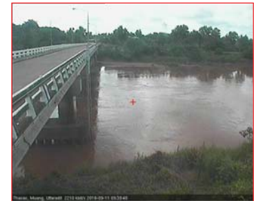
สถานีสะพานท่าเสา อ.เมือง จ.อุตรดิตถ์ (ลุ่มน้ำน่าน)
