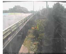
สะพานข้ามแม่น้ำท่าจีน ทางหลวง3365 อ.สามชุก จ.สุพรรณบุรี (ลุ่มน้ำท่าจีน)
