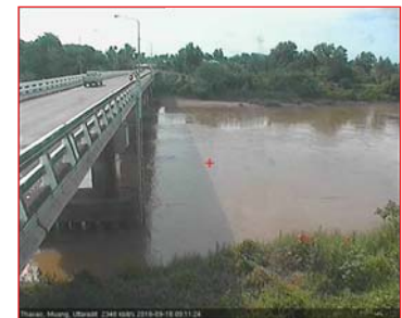
สถานีสะพานท่าเสา อ.เมือง จ.อุตรดิตถ์ (ลุ่มน่าน)
