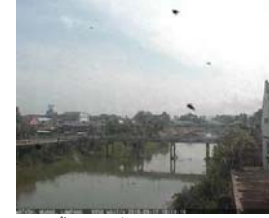
วัดเกาะวาศุภาราม - อ.เมือง จ.ลำปาง (ลุ่มน้ำวัง)
