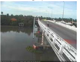
สะพานบุญรัตนประชาวุฒัน - อ.สามพราน จ.นครปฐม (ลุ่มน้ำท่าจีน)
