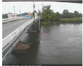
สะพานหลวงพ่อบิน - อ.นครไชยศรี จ.นครปฐม (ลุ่มน้ำท่าจีน)
