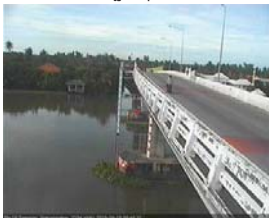
สะพานบุญรัตนประชาวุฒิน - อ.สามพราน จ.นครปฐม (ลุ่มน้ำท่าจีน)
