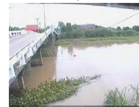
สะพานสามง่าม-ท่าโบสถ์ อ.หันคา จ.ชัยนาท (ลุ่มน้ำท่าจีน)
