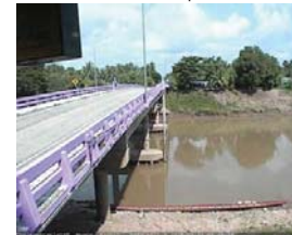
สะพานเฉลิมพระเกียรติ 48 พรรษา อ.เมือง จ.พิจิตร (ลุ่มน้ำ่าน)
