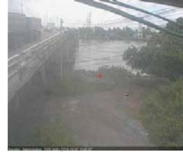
สะพานข้ามแม่น้ำท่าจีน ทางหลวง346 อ.บางเลน จ.นครปฐม (ลุ่มน้ำท่าจีน)
