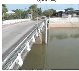
สะพานพระแม่ย่า - อ.เมือง จ.สุโขทัย (ลุ่มน้ำยม)
